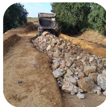
Figure 14. Travaux d'aménagement de la piste cyclable entre Le Boulou et Villemolaque
